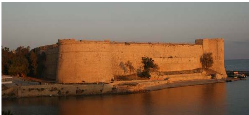
Kyrenia/ Girne: Gesamtansicht der Festung von Osten.
