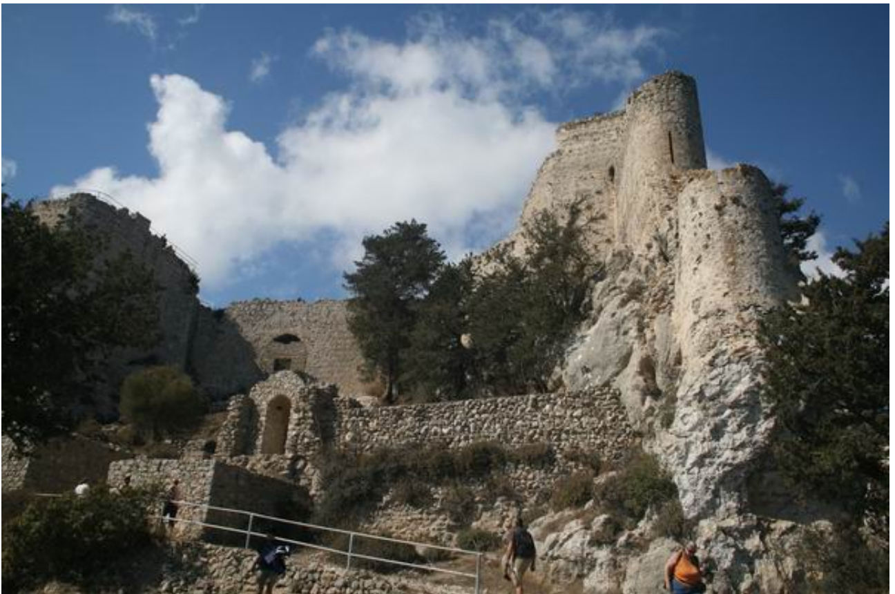
Kantara: Vorbefestigung (Barbarkane) der Vorburg mit dem Burgzugang. Links oben befindet sich eine sehr schmale Bogenschützengalerie.
