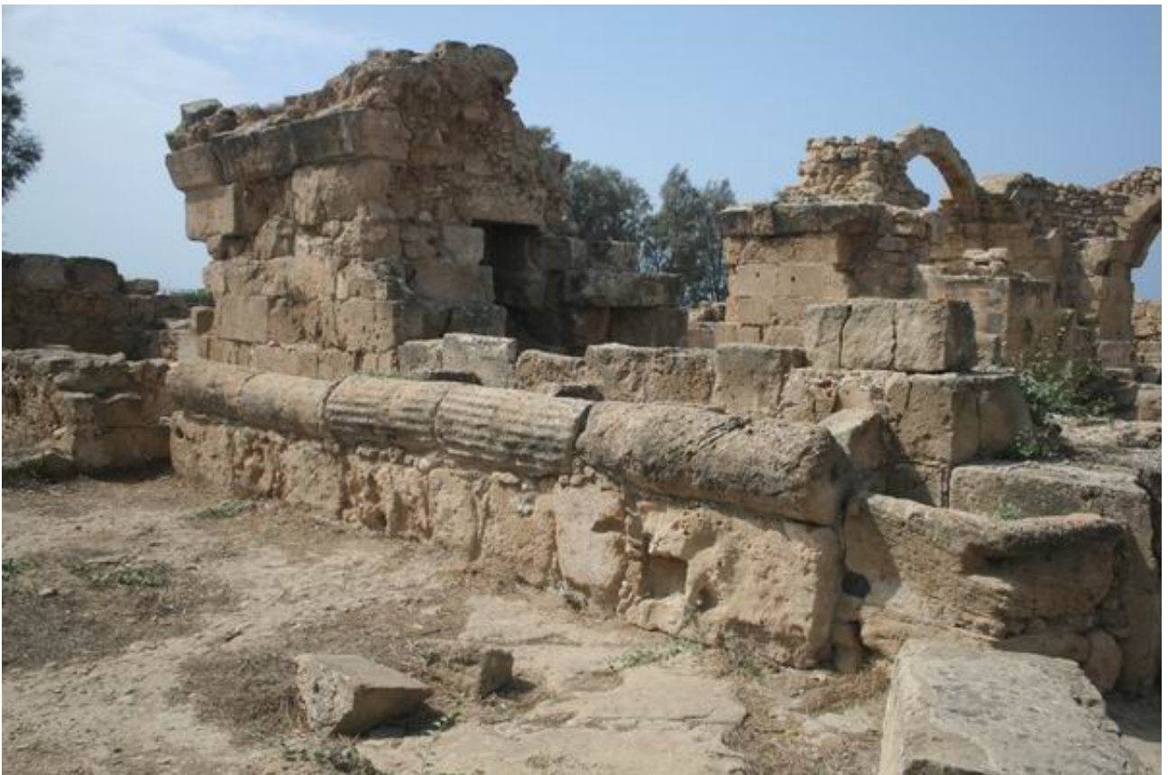
Paphos, Saranda Kolones: Stallgebäude in der inneren Burg. Für den Bau der Futterkrippen verwendete man antike kannelierte Säulensegmente. Der Name der Burg, der auf Deutsch „Vierzig Säulen“ heißt, wird auf die Verwendung einer Vielzahl von Spolien zurückgeführt.
